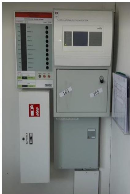
Hoone ATS keskseade ja tuleohutussüsteemide juht- ja infopaneel
