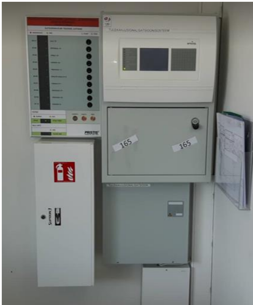
Foto. Hoone ATS keskseade ja tuleohutussüsteemide juht- ja infopaneel.
